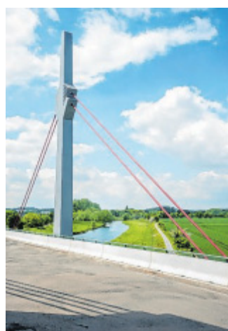
Aktuell: Die Tragebrücke der Nordumgehung über die Werre. FOTO: SAGURNA/LWL
